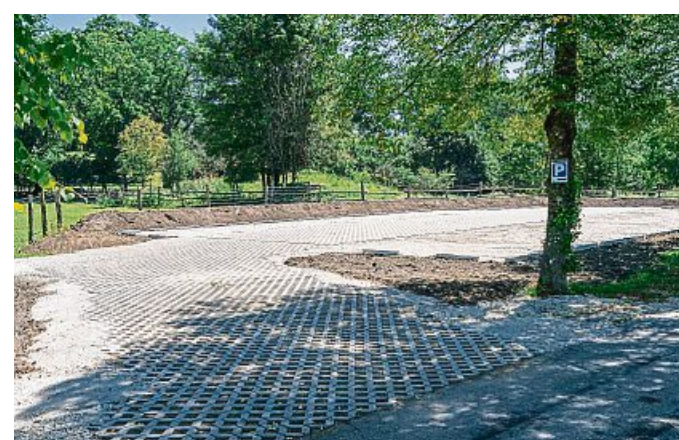
Nördlich von Gut Dietlhofen, direkt an dessen Zufahrtsstraße von der B 2, liegt der neue Parkplatz für ca. 40 Autos. FOTO: RR
